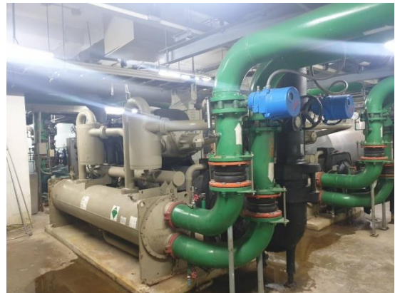
ภาพแสดง ระบบระบายความร้อนด้วยน้ำของเครื่องปรับอากาศ
